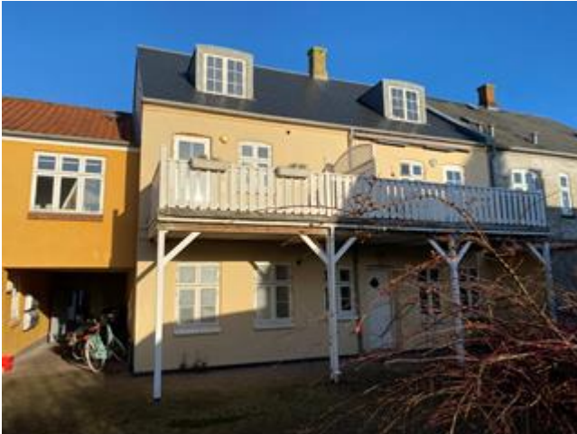
Ejendommens facade bagfra
